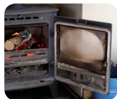
**Un millimètre de suie** déposé dans le conduit de fumée, c'est 10 % de consommation de bois supplémentaire.
